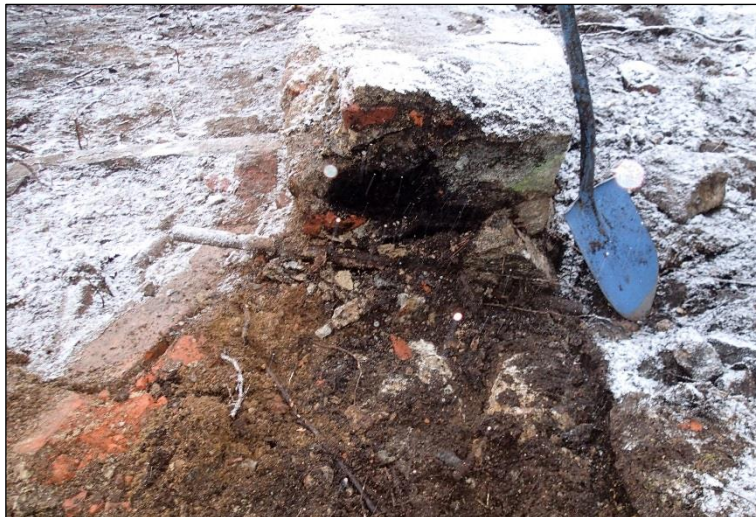
Tiilikaukalosta peruskiven alta menevä rautaputki.
